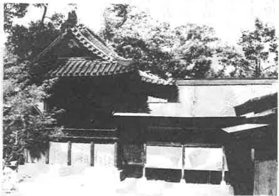
修復工事を終えた郷社本殿
